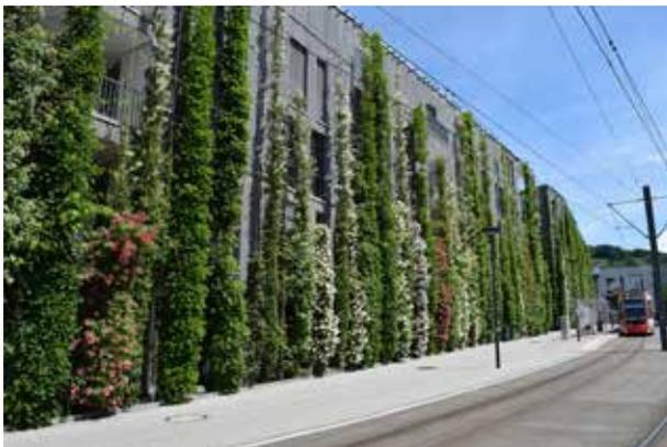
Abb. 6: Bodengebundene Fassadenbegrünung mit Kletterhilfe.
